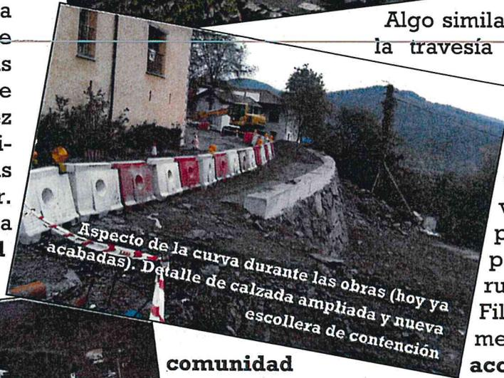
Aspecto de la curva durante las obras (hoy ya acabadas). Detalle de calzada ampliada y nueva escollera de contención
